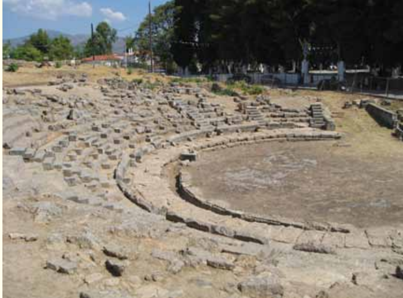
Εικ. 16. Ορχήστρα και αγωγός αποστράγγισης των υδάτων της βροχής του αρχαίου θεάτρου Ορχομενού.
