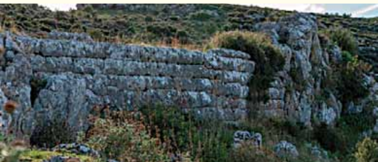
Εικ. 4. Τμήμα ισόδομης οχύρωσης ακρόπολης Χαιρώνειας (Πετραχός).
