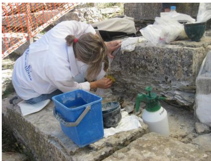
Από τις εργασίες πλήρωσης των μεγάλων ρωγμών
